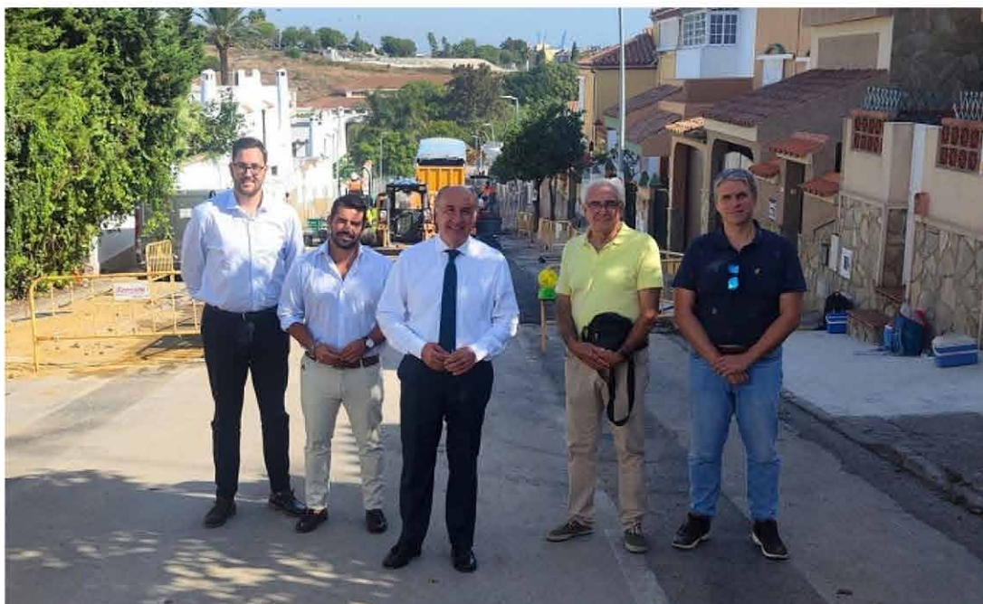
Un momento de la visita a las obras. / FOTO: AAM
